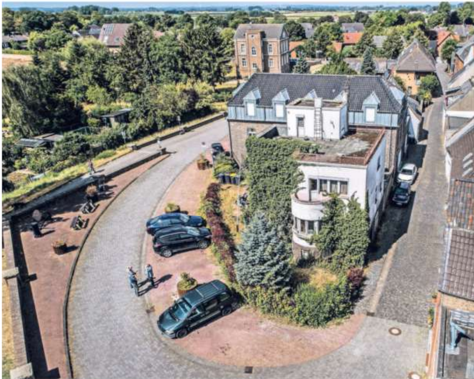
Bauhaus in Grieth mit Rheinblick. Genial hat der Architekt den Bau auf das dreieckige Grundstück gesetzt.
