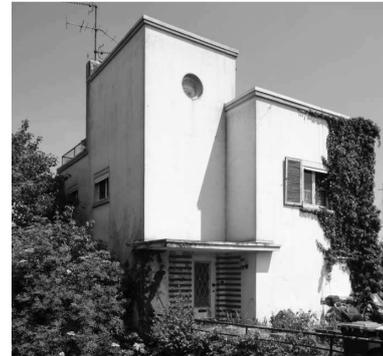
Zur Seitenstraße Fischerwall hin tritt das Sockelgeschoss als Vollgeschoss in Erscheinung, mit eingebauter Garage. Der Baukörper als für das Neue Bauen typisches Terrassenhaus in der Höhe insgesamt dreifach gestuft, der höchste Teil turmartig mit kleinem Rundfenster über dem Eingang; Flachdächer, z.T. als Dachterrasse mit filigranen Metallbrüstungen ausgebaut; leicht vortretende Trauflinien.
