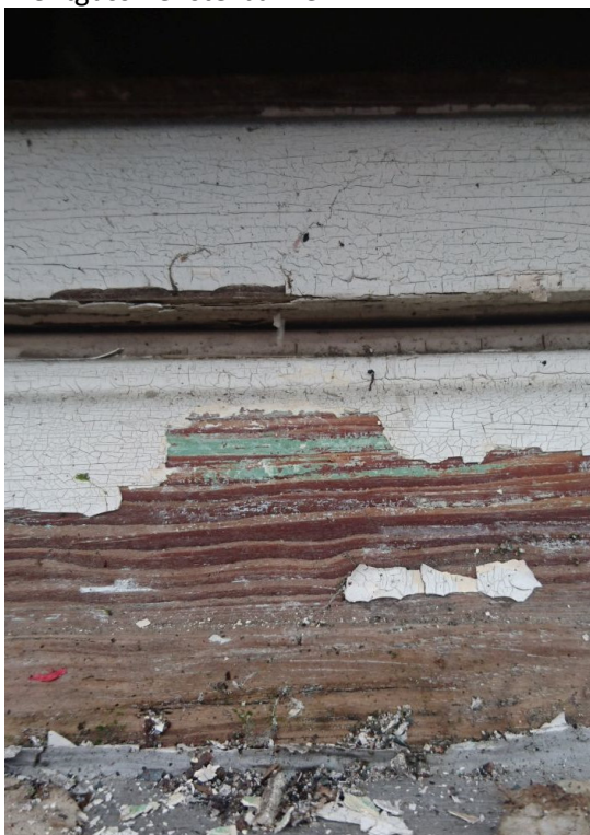
Vergilbter Blauanstrich der Fenster
