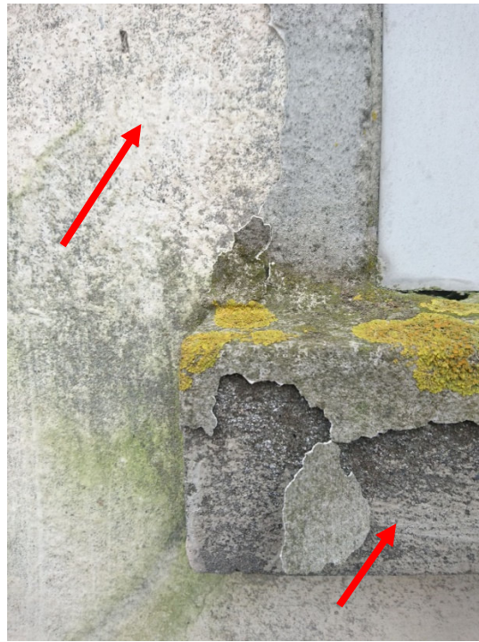
Kalkweißer Erstanstrich des grob geriebenen Fassadenputzes mit hellgrau gestrichenen Zementguss-Fensterbänken
