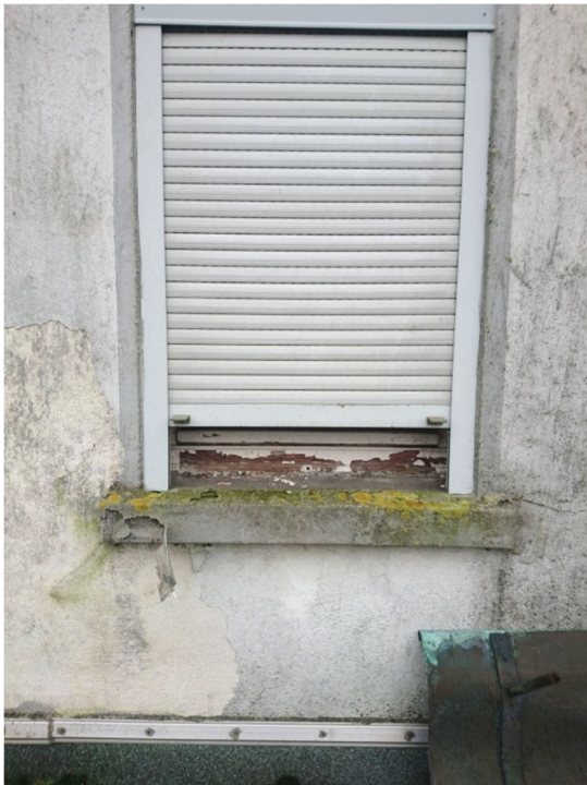
Kalkweißer Erstanstrich des grob geriebenen Fassadenputzes mit hellgrau gestrichenen Zementguss-Fensterbänken
