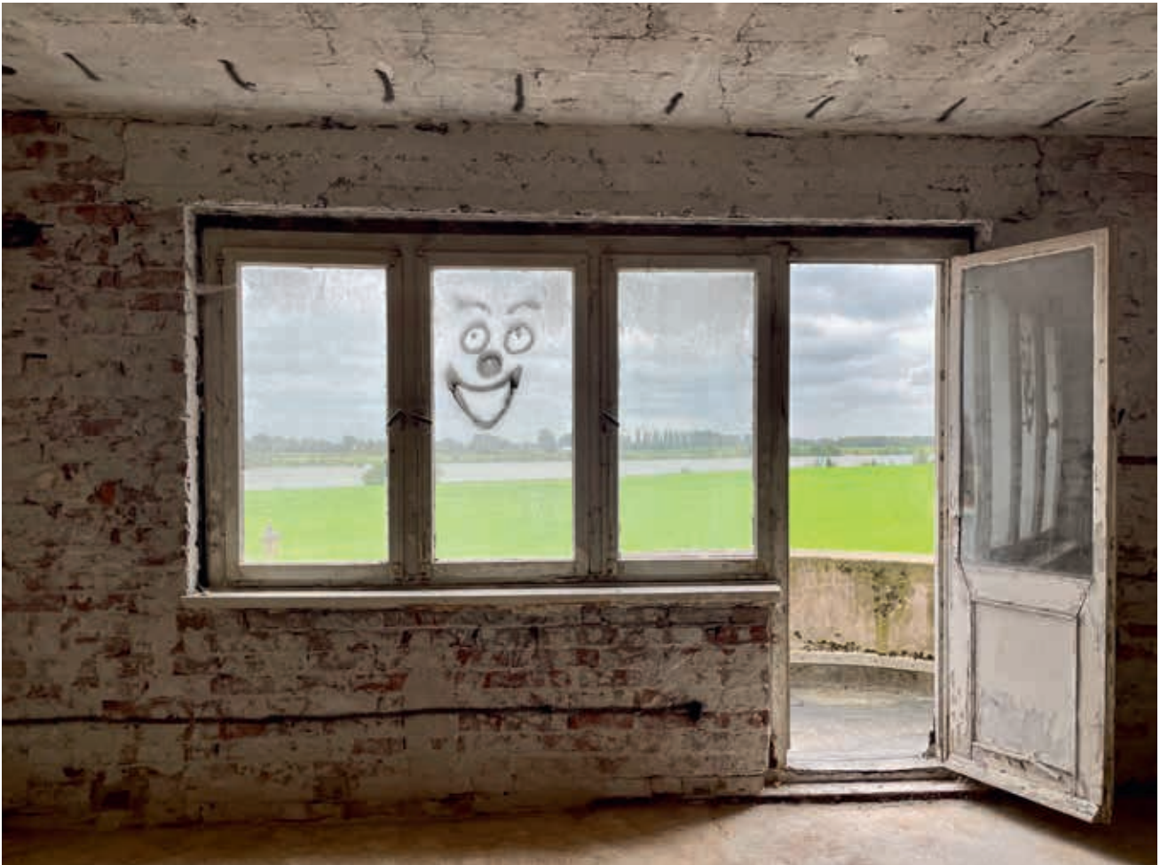
Ausblick vom Obergeschoss mit Austritt auf einen abgerundeten Balkon
