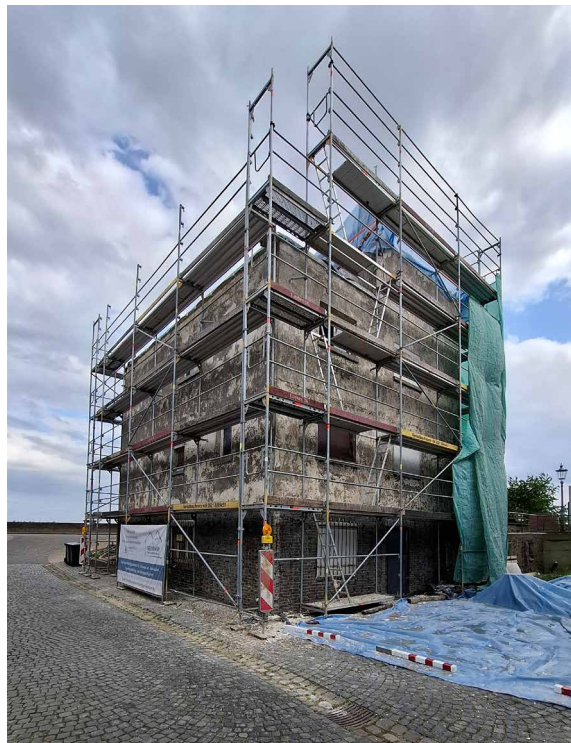
Instandsetzungsarbeiten. Foto: Lutz Kühnen
