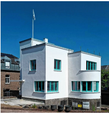
Ein Hingucker: Das Haus Haan nach dem Umbau ohne Bauge-rüst.
